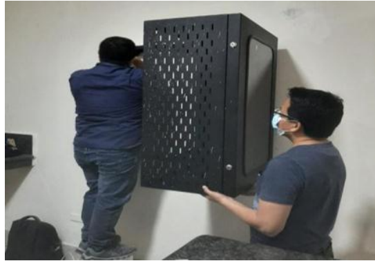
Ilustración 9. Instalación de gabinetes de comunicaciones
