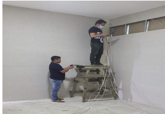
Ilustración 10. Despliegue del cableado
