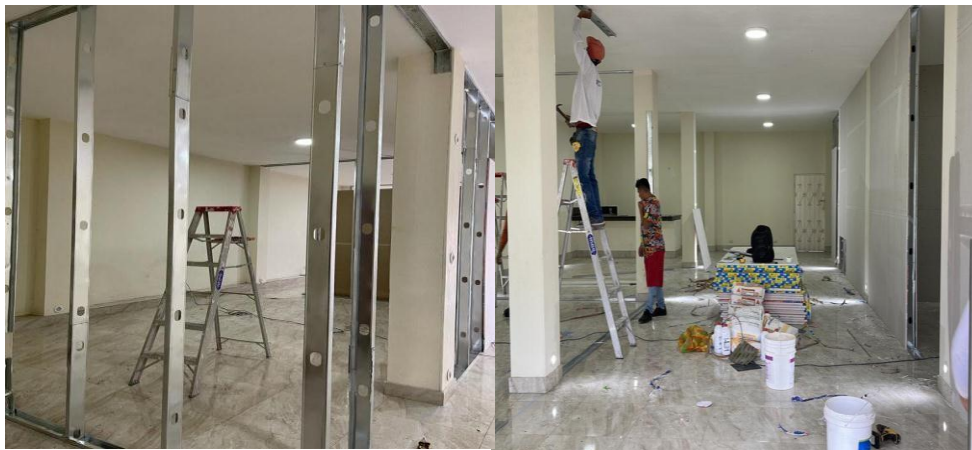
Ilustración 7. Estructura metálica para divisiones
